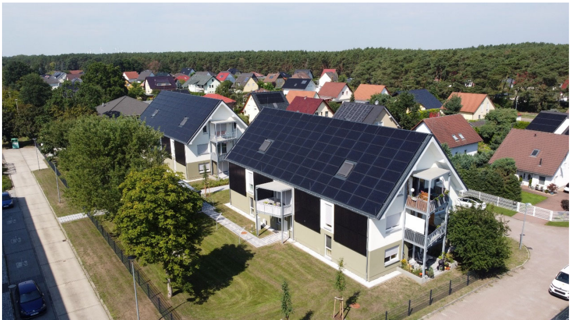
↗ Abb.6: Lübben, Baujahr 2022 zwei hochgradig energieautarke Mehrfamilienhäuser mit je 7 Wohneinheiten, enttechnisiert mit Infrarotheizung und dezentraler Warmwasserbereitung, solare Deckung etwa 50 Prozent (Strom und Wärme), Solartechnik auf dem Dach und an der Fassade, Energiespeicher; Pauschalmiete mit Energieflatrate®, für Wohnen, Wärme und Strom über mehrere Jahre hinweg garantiert.
