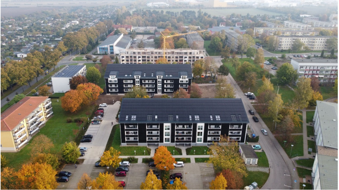
↗ Abb.9: Aschersleben, Baujahr 2022 – 2025; Quartierslösung: erste sanierte ehemalige DDR-Plattenbauten drei hochgradig energieautarkes Mehrfamilienhäuser mit insgesamt 22 Wohneinheiten, enttechnisiert mit Infrarotheizung und Autarkie-Boiler® (dezentraler Warmwasserbereitung), solare Deckung etwa 60 Prozent (Heizung, Warmwasser und Haushaltsstrom), Solartechnik auf dem Dach und an der Fassade, Energiespeicher; Pauschalmiete (11,50/m 2 ) mit Energieflatrate, für Wohnen, Wärme, Strom und E-Mobilität über 5 Jahre hinweg garantiert.
