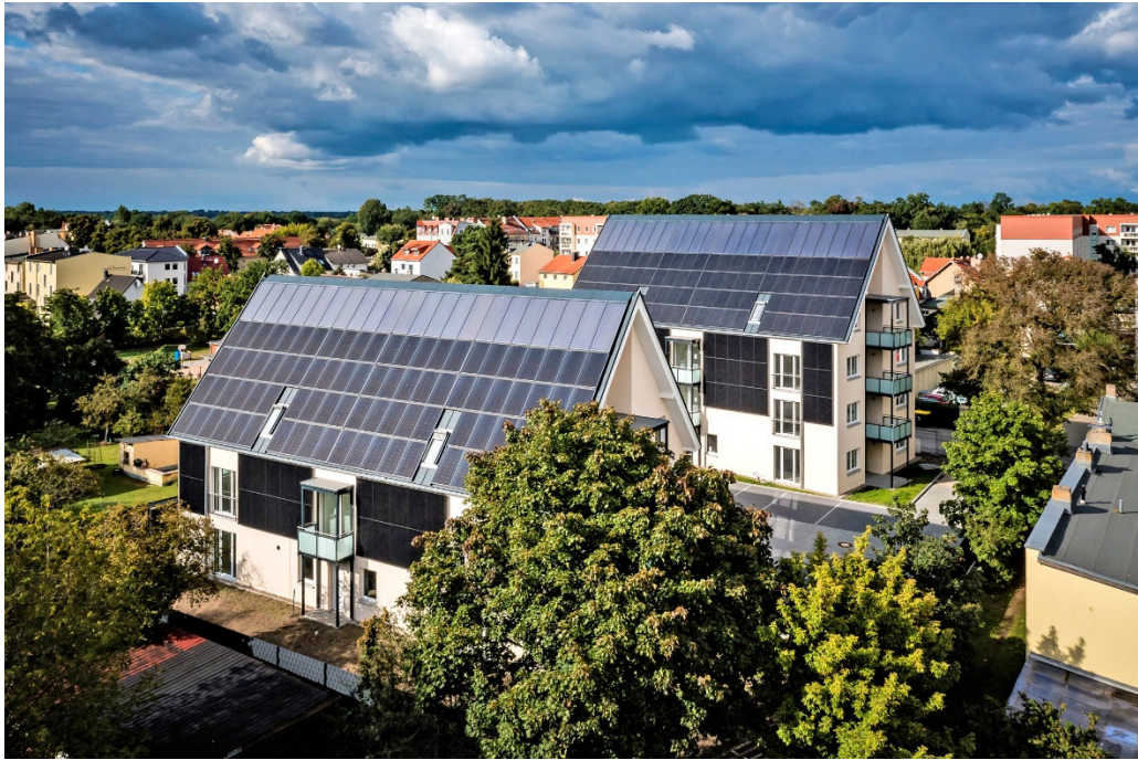
↗ Abb.5: Oranienburg, Baujahr 2021 zwei hochgradig energieautarke Mehrfamilienhäuser mit 6 und 8 Wohneinheiten, solare Deckung etwa 70 Prozent (Strom und Wärme), Solartechnik auf dem Dach und an den Balkonen, Energiespeicher; Pauschalmiete mit Energieflatrate®, für Wohnen, Wärme und Strom über mehrere Jahre hinweg garantiert. Quelle: HELMA
