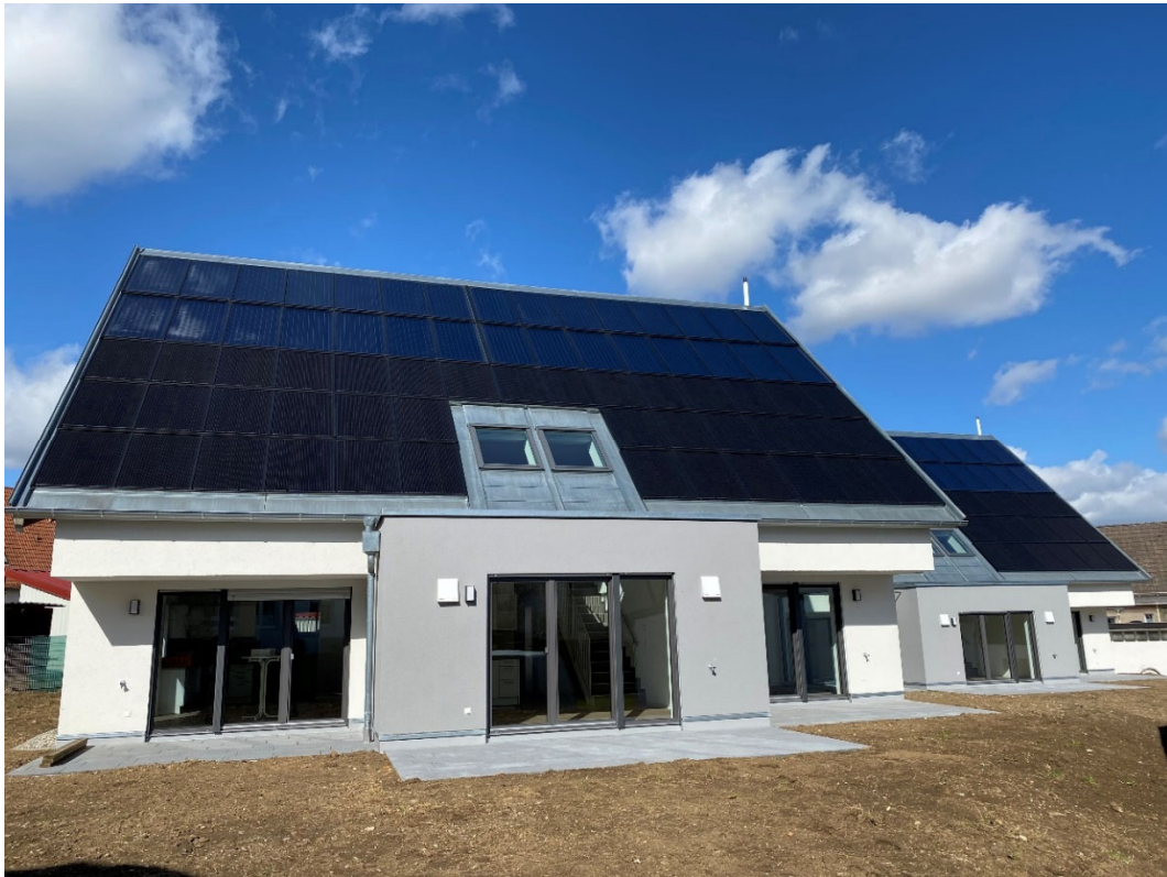
↗ Abb. 11: Als erste Bank Deutschlands baute die VR-Bank Ostalb eG Aalen 2019 in Aalen zwei energieautarke Mehrfamilienhäuser mit je drei Wohneinheiten. In der Pauschalmitte mit Energieflrat sind die Kosten für Wärme, Strom enthalten.
