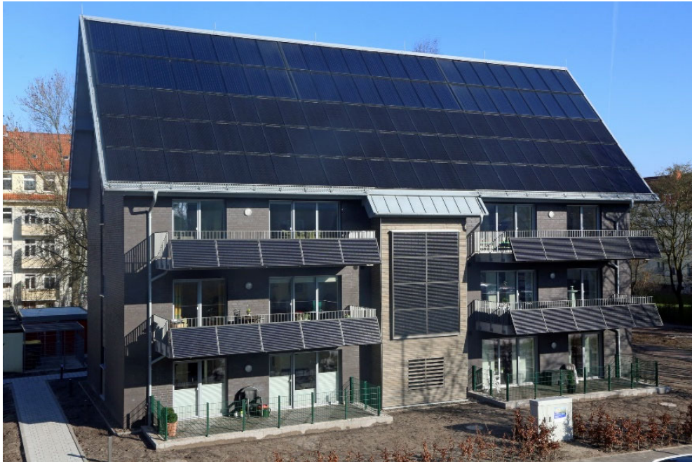
↗ Abb. 4: Wilhelmshaven, Baujahr 2018
